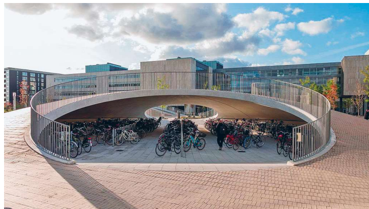
Cykelparkering integreret i byrummet ved Københavns Universitets nye Søndre Campus, Karen Blixens Plads. Foto: Visit Copenhagen.
