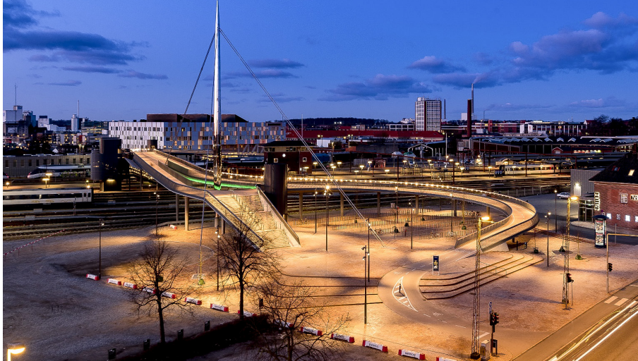
Figur 3. Under Byens Bro er der etableret 800 nye stativer til pendlere.
