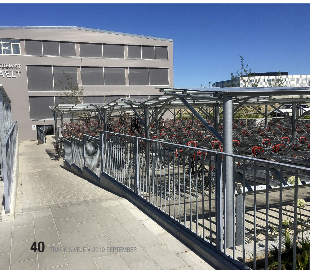
Figur 1. Privat cykelparkering ved en ny uddannelsesinstitution, som opfylder krav om kapacitet, komfort og sikkerhed.
