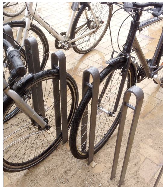
Figur 4. Odense Kommunes standardstativ kan produceres af alle, således at der konkurreres på prisen. I bymidten er de lakerede, ellers er de galvaniserede.
