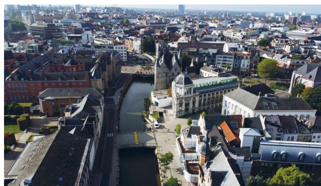
Simple betonklodser på kanalbroerne reducerer adgangen for biler, men fastholder den attraktive smutvej for cyklister i Gent.
