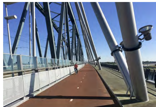
Figur 1. Stibro bygget på en eksisterende jernbanebro med rigelig bredde til både cyklister og fodgængere.
