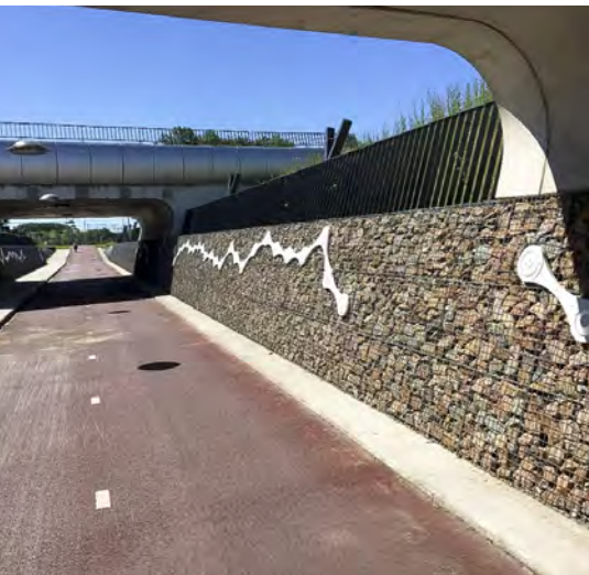
Figur 2. Nye stitunneller med fortov og LED dekorationslys.
