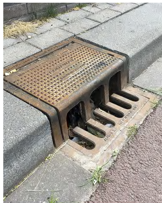
Figur 5. Sideløbsdræn er standard på de fleste hollandske cykelstier.
