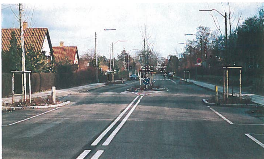
Figur 1. L. A. Ringsvej. Stillevej ved skole. (Kragssbjergskolen).
