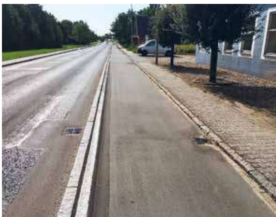
Spareudgaven af en supercykelsti, hvor der blot er sat en ekstra kantsten på kørebanen. Den er valgt, fordi antallet af cyklister er ret lille her.
